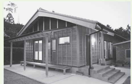
▲左右内製材が施工した木造住宅
