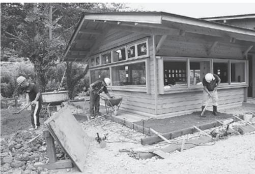
▲型枠に土を敷き詰め、突き固めていく
