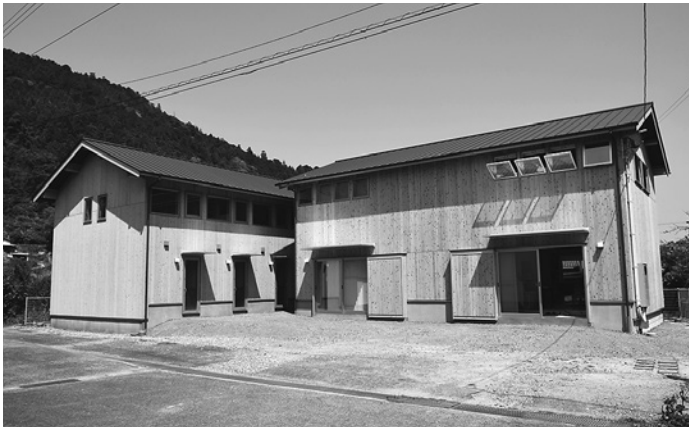
▲向かって右側がB棟、左側がC棟
