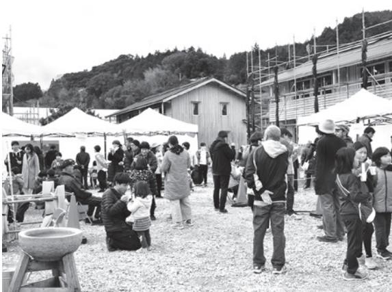
▲建設中の大塋地住宅を眺めながらお汁粉を楽しむ
