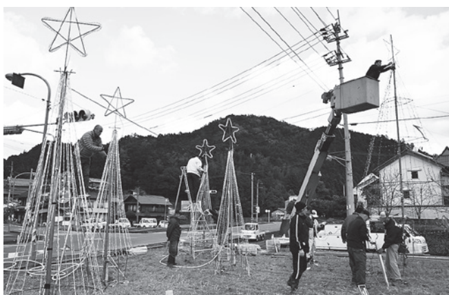
▲高所作業車を利用してツリーを設置
