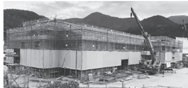
〈北西面道路より外観状況〉
