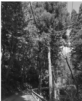
電線に樹木が接触している
