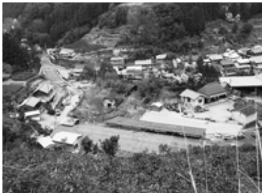
工事中の川又工区
