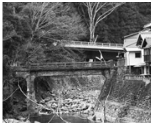
完成した新しい川又橋と旧の川又橋
