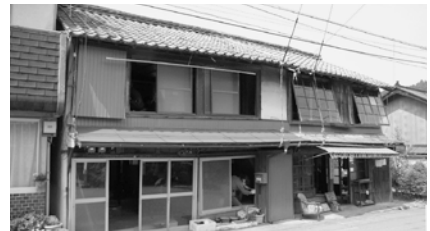
△改修前 平成22年5月
