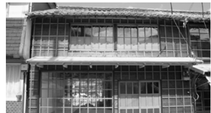
△改修後 平成22年10月
