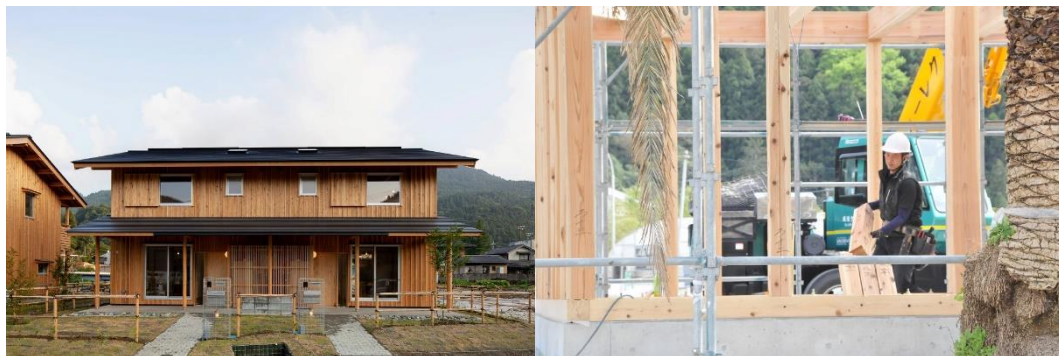
(左) 町産材で建てられた大埜地の集合住宅居 (右) まちの大工による建築の様子
