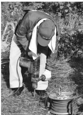
▲土の下はコンクリートのため、機械で穴を開けて支柱を立てます
