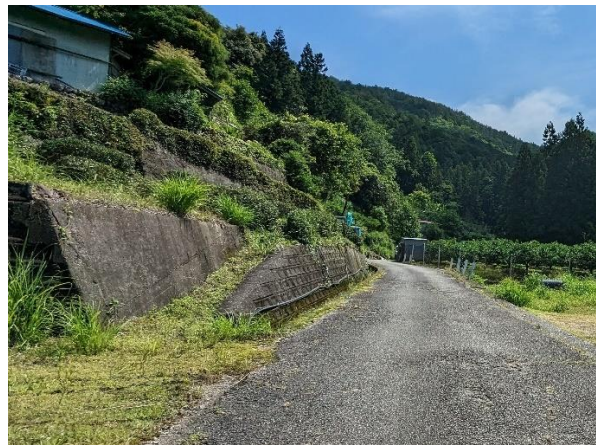
車道を整備する際に、コンクリート護岸や練石積みに切り替えられた道路擁壁
