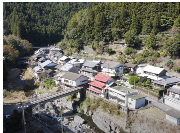
道路に面して建物が建ち並び、建物の壁面がそろっている(上分・川又)
