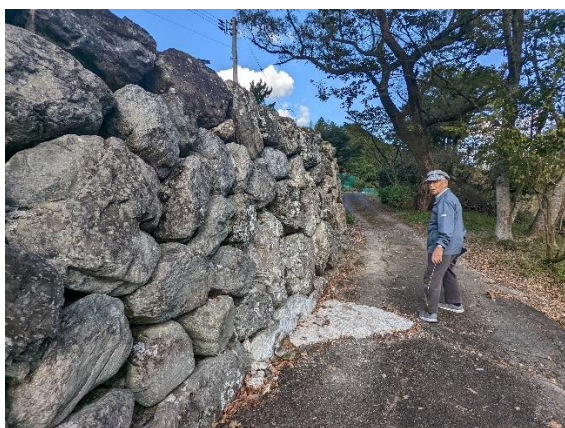
鮎喰川の側にある住居を支えるための石積み
