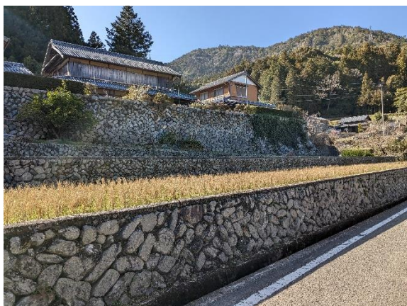
住居を支える石積み
