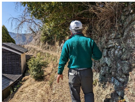
人専用の道路擁壁として作られた石積み
