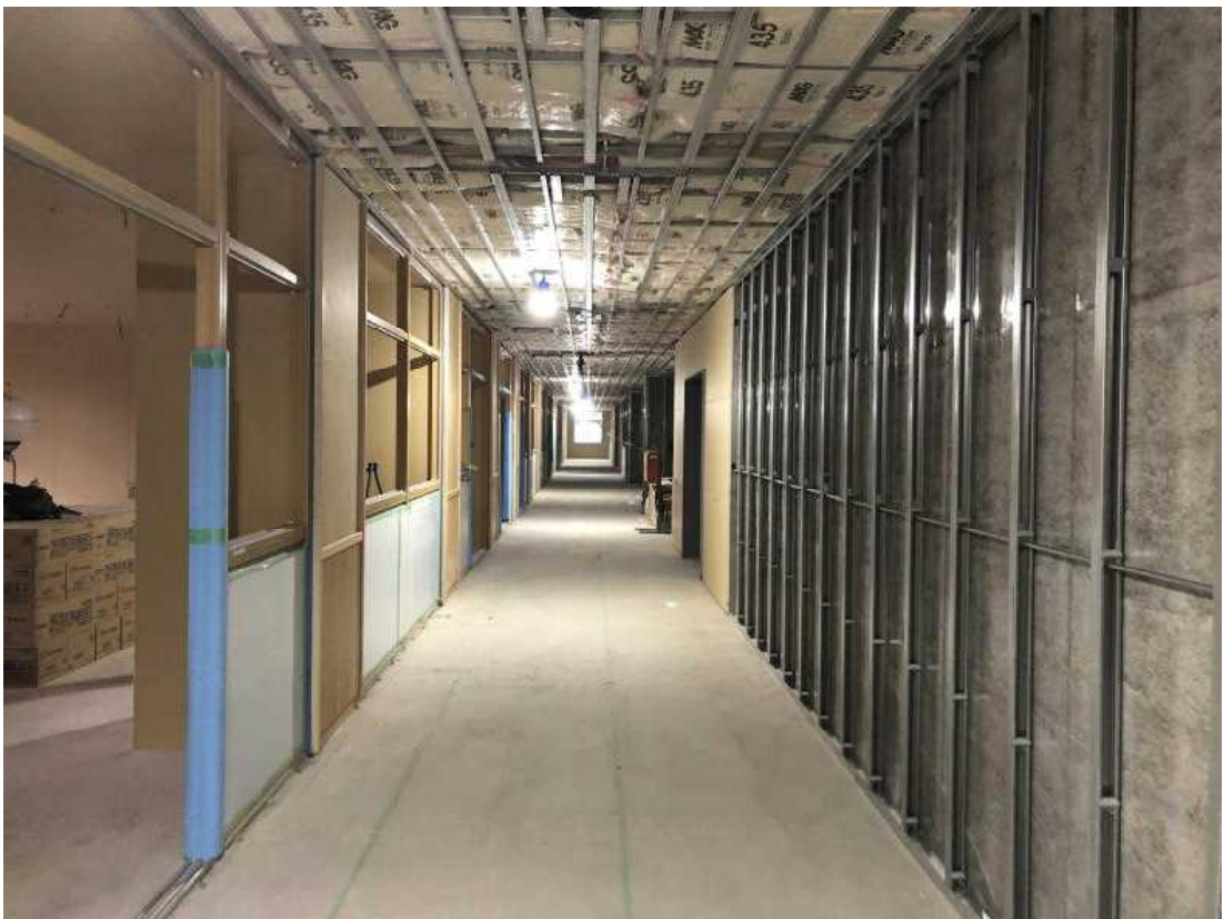
(3階廊下の状況)
