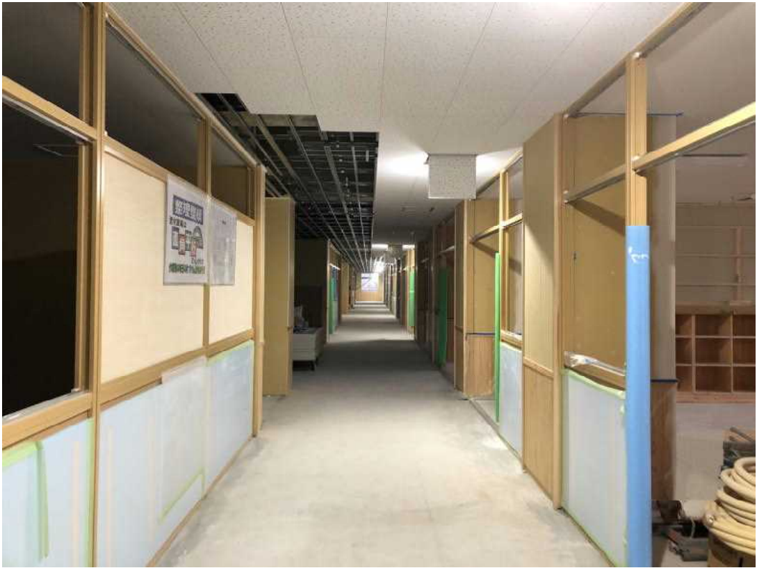
(2階廊下の状況)
