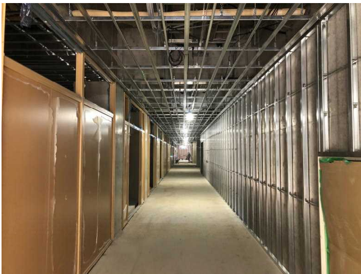
← 内部 1 階廊下の状況
