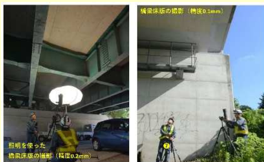
【BR010002-V0020 超望遠レンズによる高層構造物の外観検査技術】
