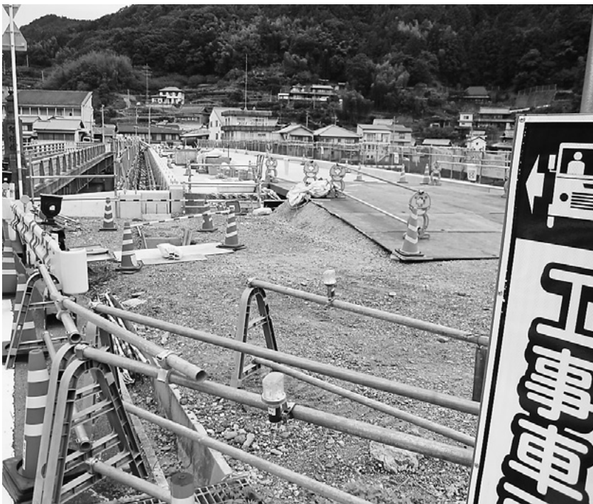
年度内の開通をめざして工事の進む阿野橋
