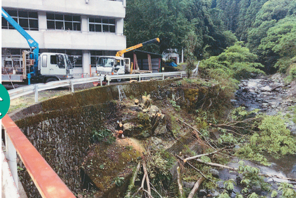
■旧上分中学校舎廻り樹林伐材作業
