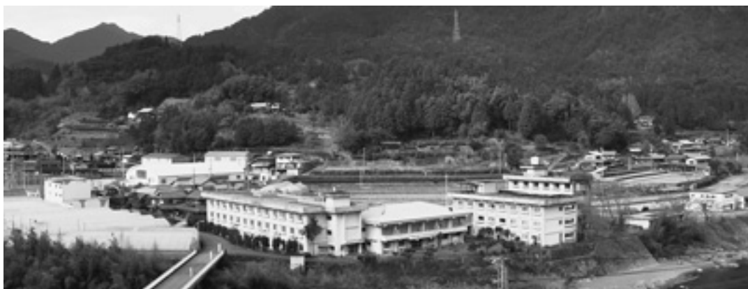
集合住宅の建設予定地（神領字大埜地）
