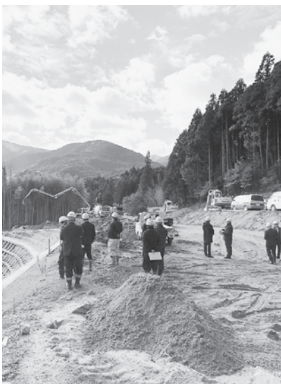
第2期高専用地造成工事現場
