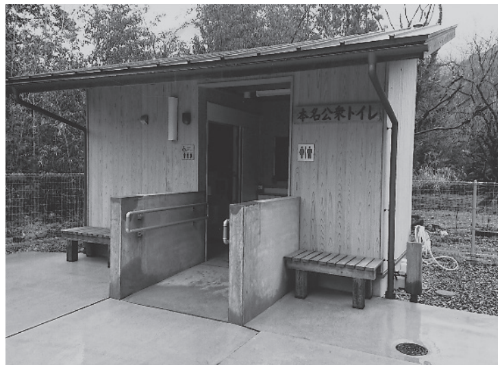
新築された本名公衆トイレ
