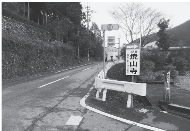
国道438号城西神山校前未拡張箇所
