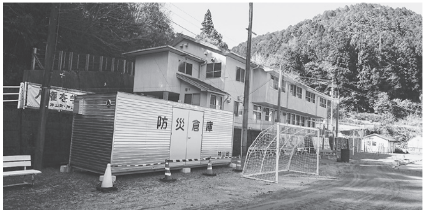
阿川公民館（避難所）と防災倉庫
