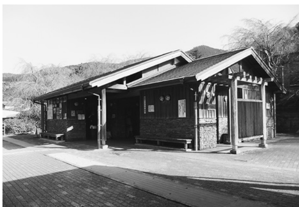
道の駅 (トイレ)
