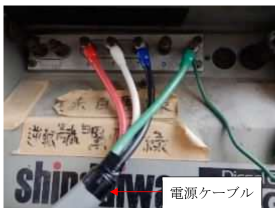
写真－８ 電源ケーブルの配線
