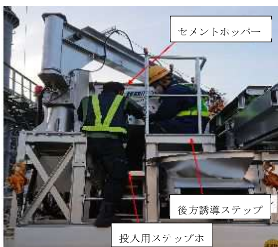
写真－１２ セメントホッパーと投入ステップ
