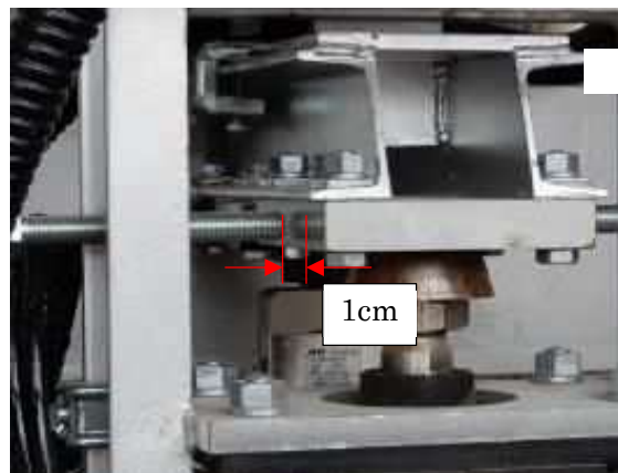
写真－１１ ボルトを緩めたロードセ
