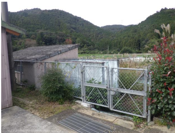
プール用具室 アスベスト含有調査
