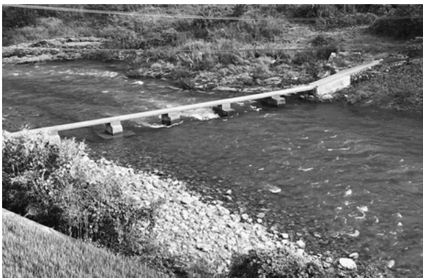
駒坂橋の現況
