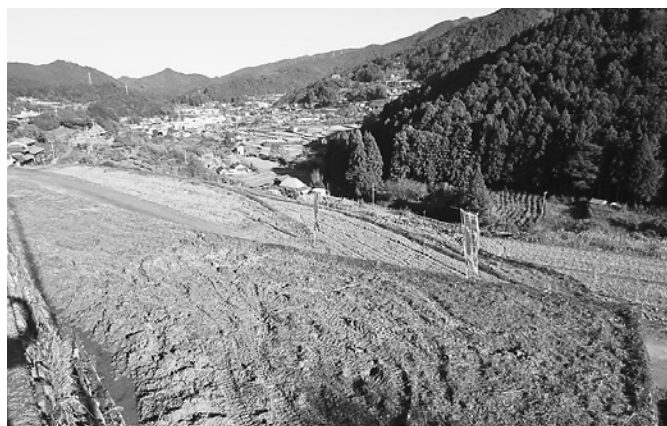
▲復旧後の様子
