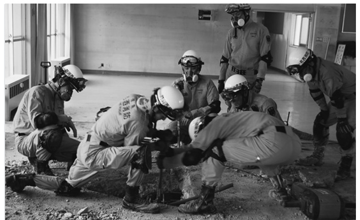
▲厚さ15cm以上あるコンクリートを砕いて穴を開け、二人がかりで太い鉄筋を切断しました。
