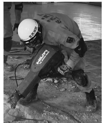
▲2階では一人通れる最適の大きさの一边が90cmの三角形の穴を開けます
