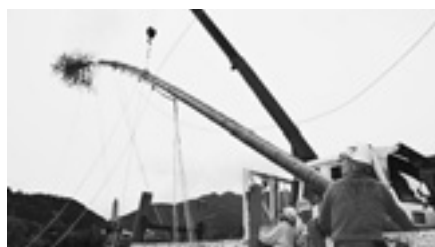
▲6月27日、大竹に滑車を取り付け、クレーン車を使って7つの土台に立てました。
