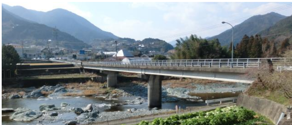
第二大埜地橋
