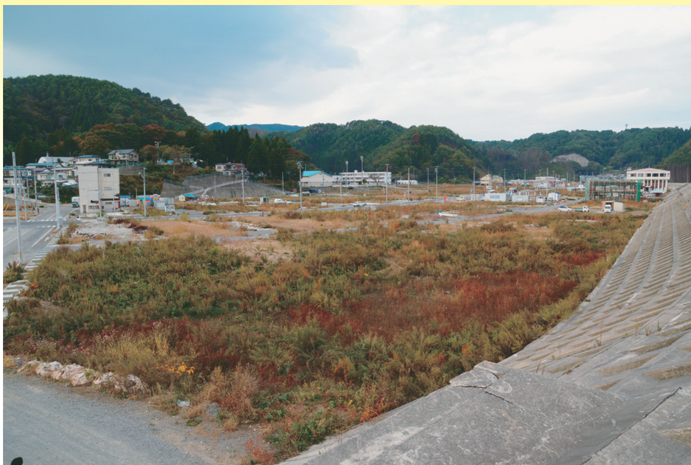
岩手県宮古市田老地区大津波の被災後風景 2012. 10. 25撮影
