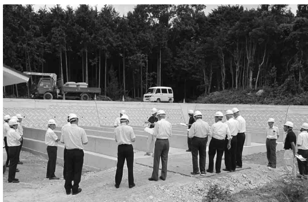
工事現場を視察
